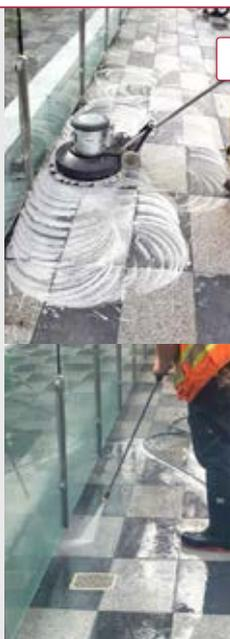
Um den nach jeder Verfugung -mehr oder minder- entstehenden Kunstharzfilm zu reduzieren, reinigen Sie die Steinoberfläche unmittelbar nach dem Abkehren mit einer 1:20 ROMPOX® - GRUNDREINIGER EXTRA : Wasser-Mischung durch mehrmaliges darüber wischen.
